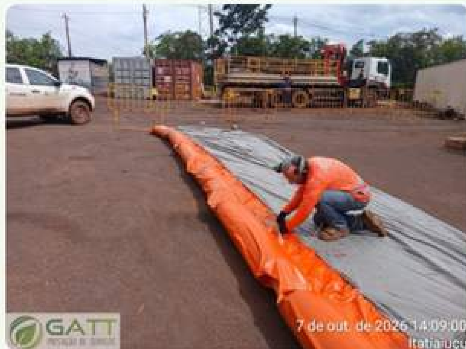
Contenção com barreira, EPI completo
