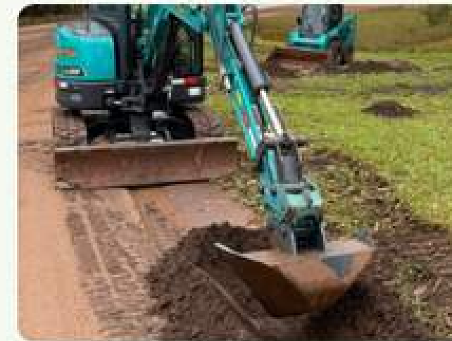
Drenagem e contenção
